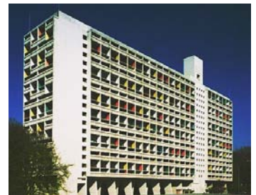
Le Corbusier (1887-1965), Unité d'habitation de Marseille (Cité Radieuse) , 1945-1952, ensemble architectural de 18 niveaux, composé de 337 appartements en duplex, de rues intérieures, d'une école maternelle, d'un gymnase, d'un hôtel, de commerces et de bureaux, 137 x 24 x 56 m, 280 boulevard Michelet, Marseille, France.
